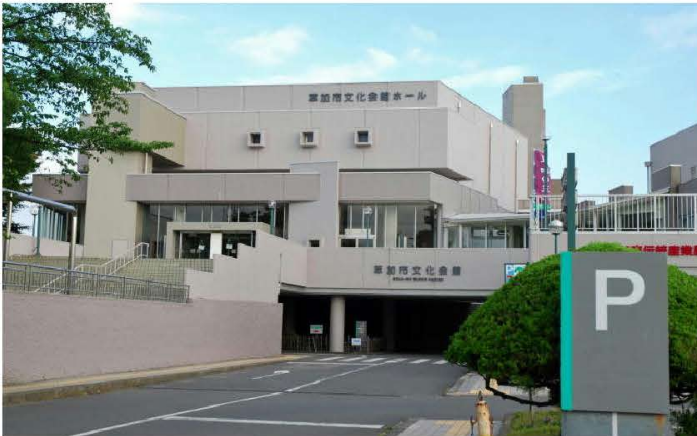
老朽化した草加市文化会館
